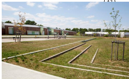
Bassin de rétention traité comme un espace public Pour une ville aimable / Grenade-sur-Garonne (31)
